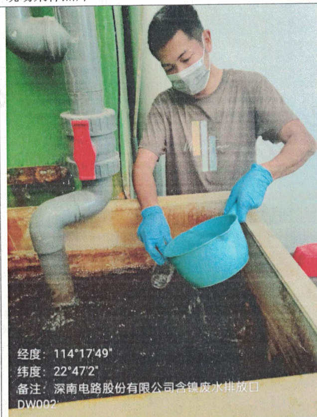
含镍废水排放口 DW002
