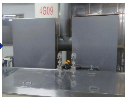
增加隔离罩、隔音棉改善后噪声 78 分贝
